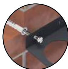
FISSAGGIO SU MURO
